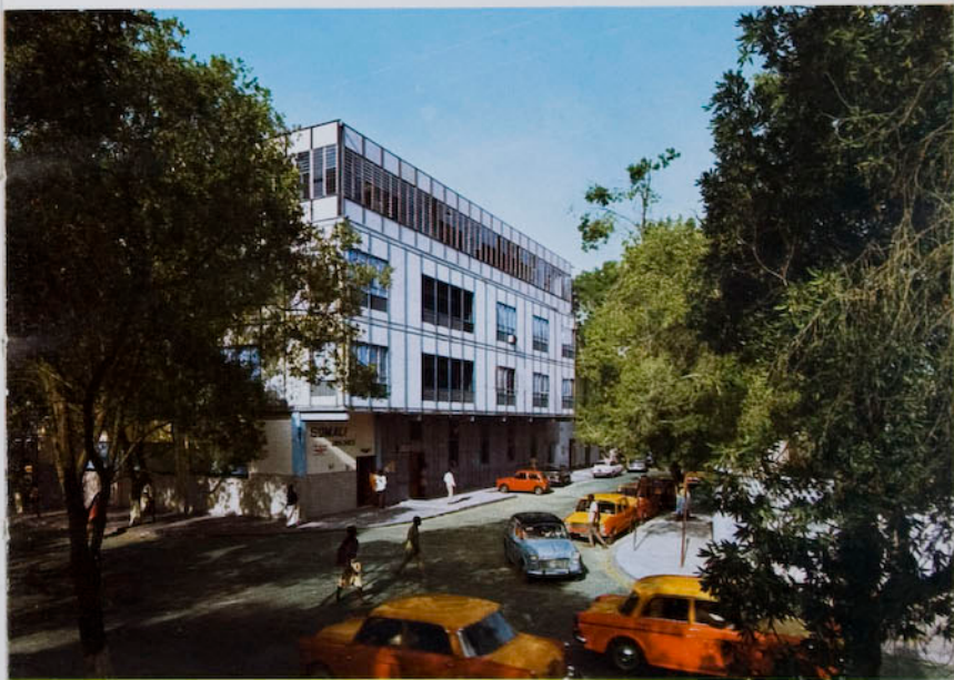
Mogadiscio. Il complesso dei servizi del Motel «Rughta Taleh».
